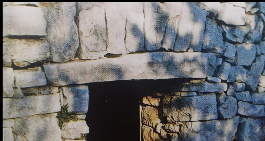
Otvor staje sa kamenim nadvojem i suhozidnim lukom koji ga rasterećuje
