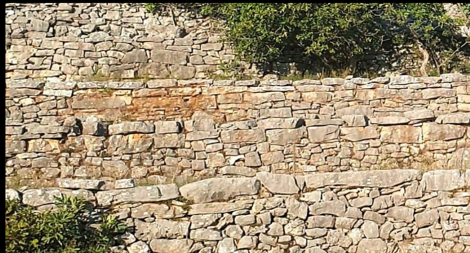
Predivni suhozidni podzidi uskih poljodjelnih terasa iznad ceste u Žakovu kod Trebinja, s detaljima
