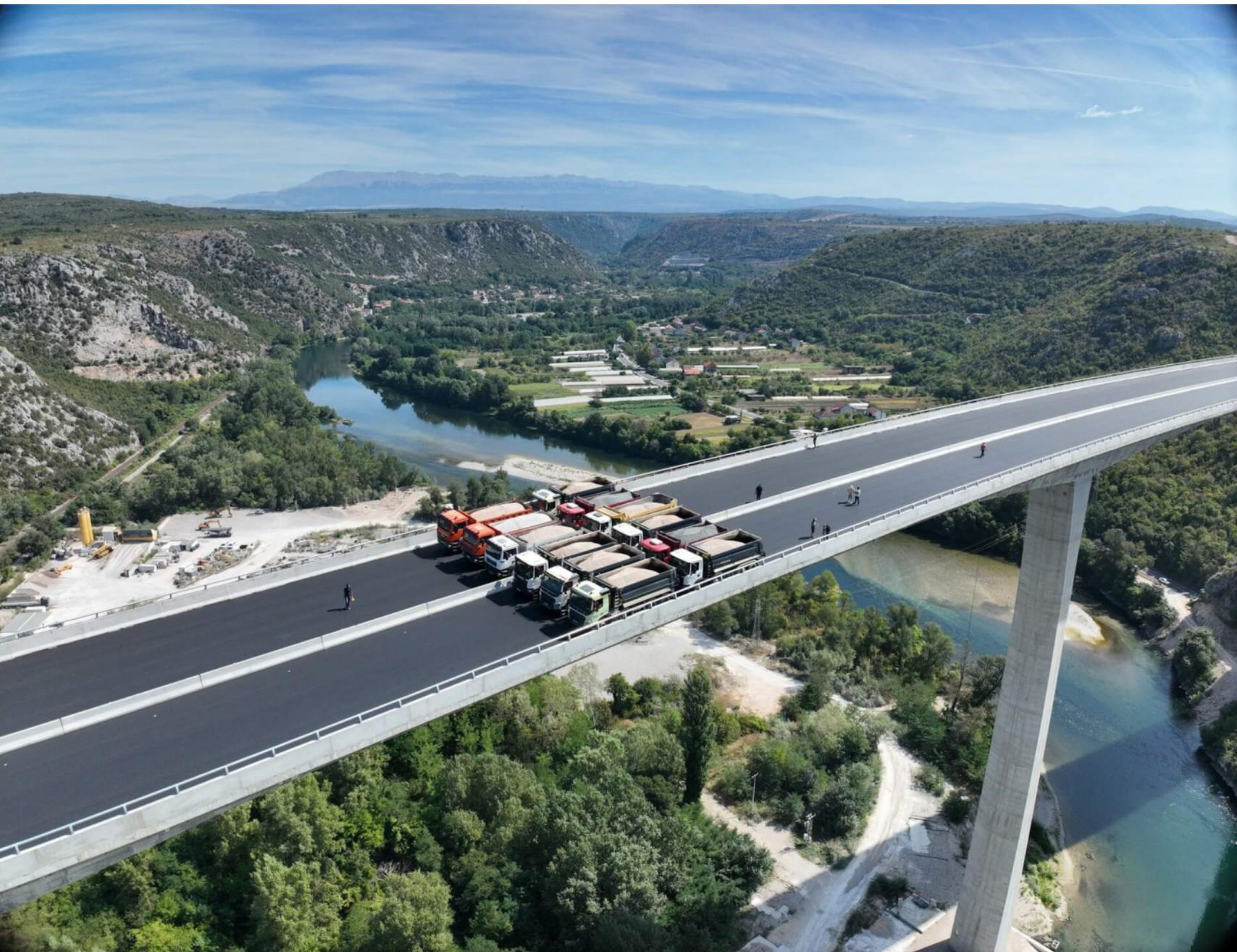
Ispitivanje probnim opterećenjem mosta Hercegovina
