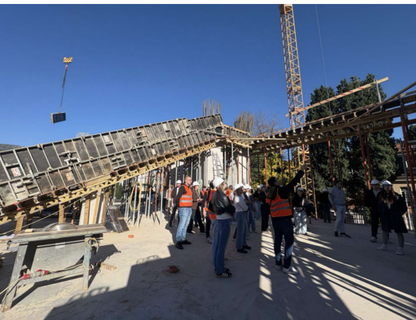
Posjet gradilištu istočne tribine stadiona HŠK Zrinjski
