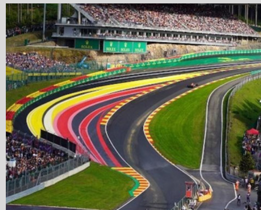
ASFALTNA RUN-OFF ZONA U ŽARKIM BOJAMA
