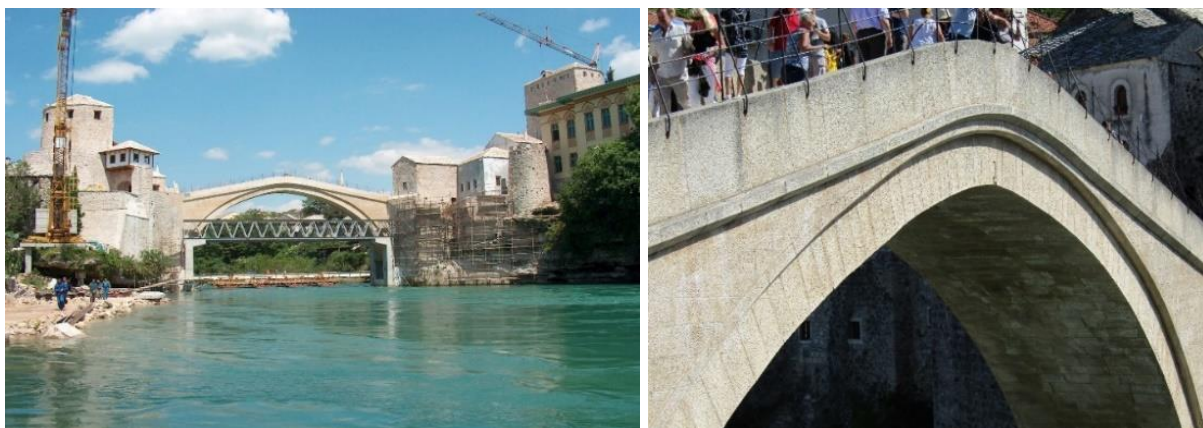
Slike 1.-2. Stari most u Mostaru, UNESCO-ov spomenik, u završnoj fazi rekonstrukcije (lijevo, 2004); Luk i čela su izvedeni od kamena tenelija (desno) (foto: K. Šaravanja)
