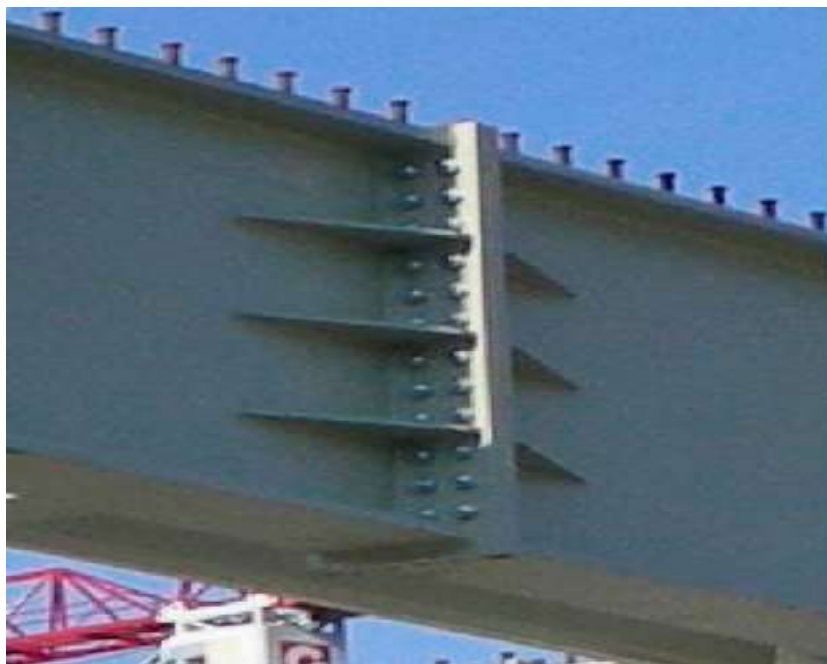
Slika 4. Montažni nastavak glavnog sačastog nosača
