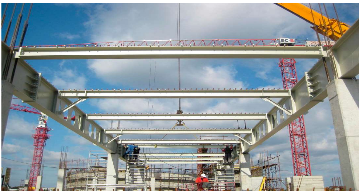
Slika 5. Montaža glavnih i sekundarnih nosača
