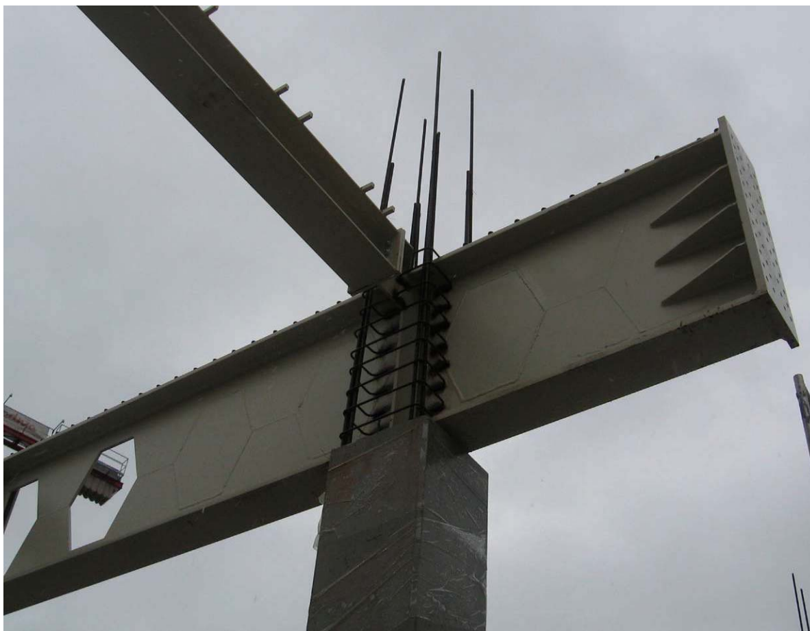
Slika 7. Detalj varenja vilica stupa za glavni sačasti nosač
