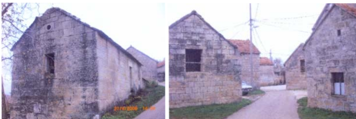
Slike 19.-20. Stambeni objekt mjesto Busari (lijevo); Stambeni objekt Ramljaci-Čitluk (desno)
