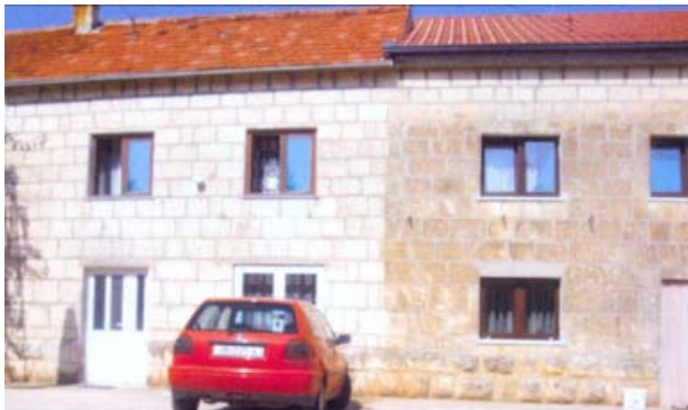
Slika 23. Primjer skidanja patine s fasade od „miljevine“
