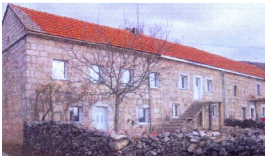
Slika 13. Obiteljska kuća u zaseoku Knezovići (Širića Brig) građena prije 80-100 godina i dograđivana; Kamen dolomit vađen u blizini, obrađen špicanjem, djelomično patinio
