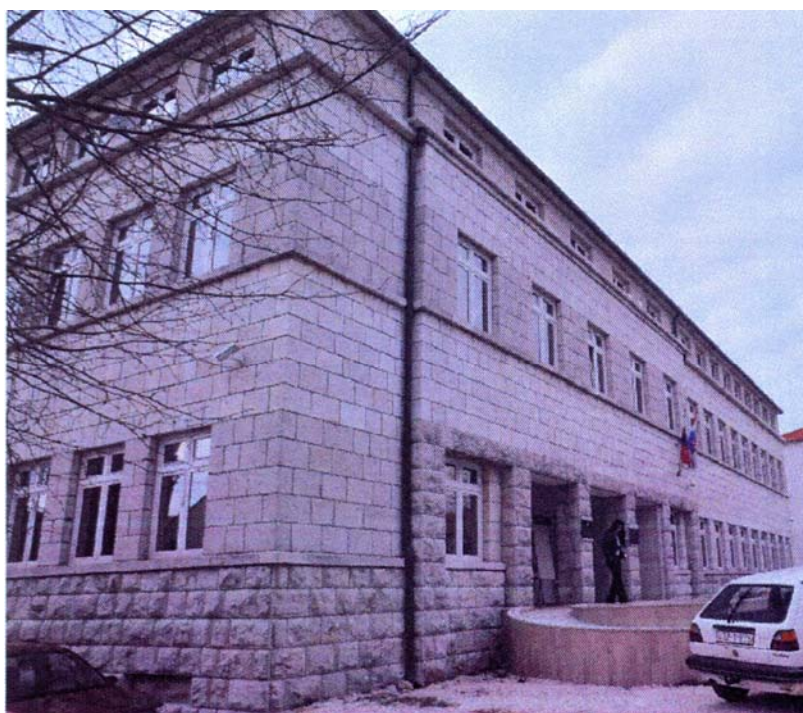
Slika 15. Zgrada općine Posušje izgrađena iza II. svjetskog rata od kamena vapnenca, gornja kreda, autohtonog porijekla, špicani, bez vidljivih promjena
