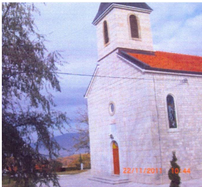
Slika 10. Župna crkva Gradac, građena krajem XIX. st. od autohtonog kamena breče gornje krede, lijepo obrađen špicanjem; zamjećuje se poneki blok dolomita; kamen nema nikakvih vanjskih promjena
