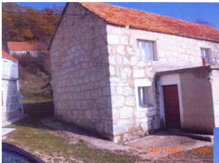
Slika 9. Obiteljska kuća u selu Zavelimu, starosti oko 80 godina, od eocenskog vapnenca, autohtonog, špicanog; Kamen nema nikakvih oštećenja od utjecaja vremena
