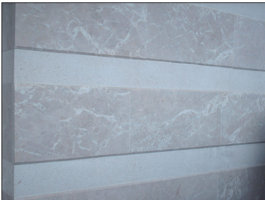
Slika 3. Detalj fasade od kamena "Hreza" na objektu u ulici Hum Brdo, op ina Vogoz a (foto Hajdarevi , 2013.)
