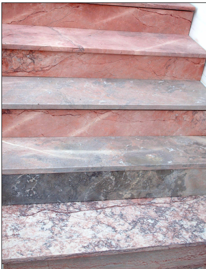
Slika 18. Fotografija reklamnog stepenizta urađenog od poliranih ploča različitih varijeteta mermerisanih kretnjaka sa lokaliteta Panje (foto Hajdarević, 2009.)
