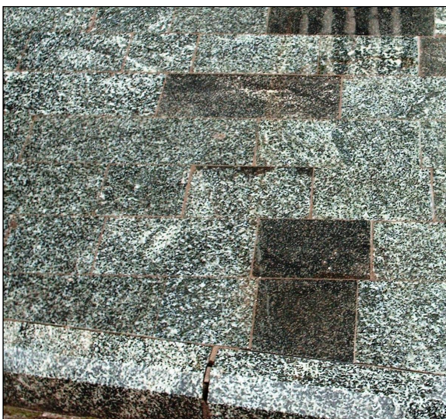
Slika 13. Dio plo nika i ivi njaci ispred privrednog objekta u mjestu Dolac na Lazvi, ura en od razli itih varijeteta gabra sa le0izta Stajizte (foto Hajdarevi , 2014.)
