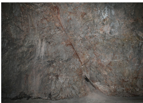
Slika 5. Pogled na prvu lokaciju
