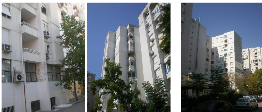
Slika 2. Parcijalni primjeri obnove pročelja pločama od ekspaniranog polistirena u Ulici Stjepana Radića u Mostaru. (Izvor: autor, 2012.)
