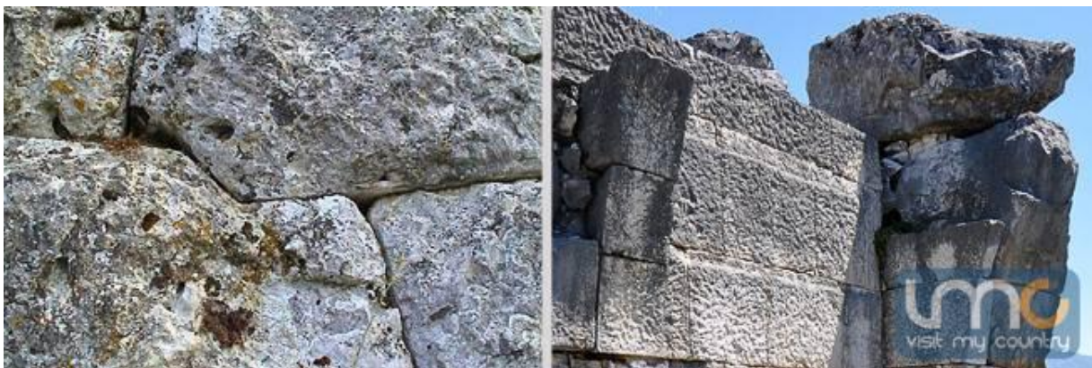
Slike 10.-11. Detalji bunjasto obrađene fasadne površine zida (lijevo); Po finoj obradi kamena lako je uočiti naknadnu pregradnju glavnih gradskih vrata (desno) 5
